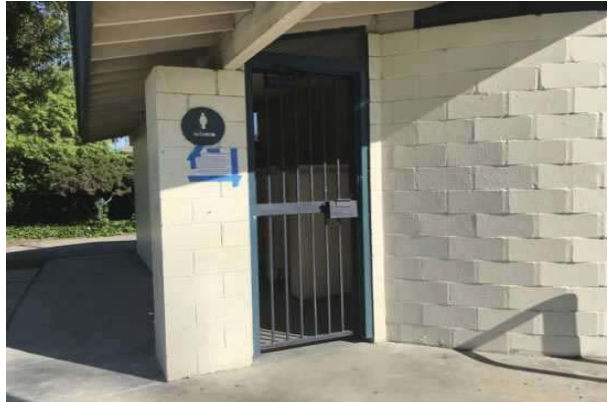
38 RESTROOM EXTERIOR DOOR
