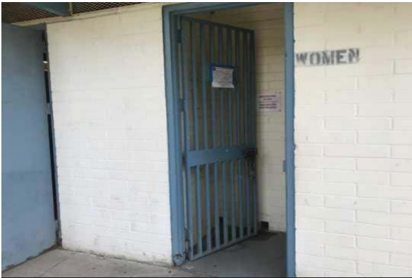
39 RESTROOM EXTERIOR DOOR
