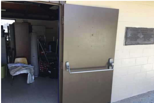
9 EXTERIOR METAL DOOR
