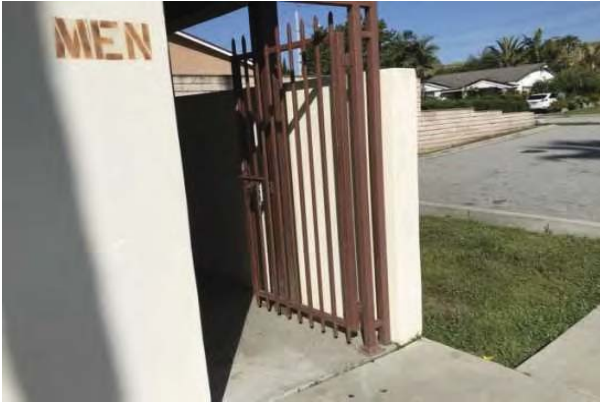
37 RESTROOM EXTERIOR DOOR
