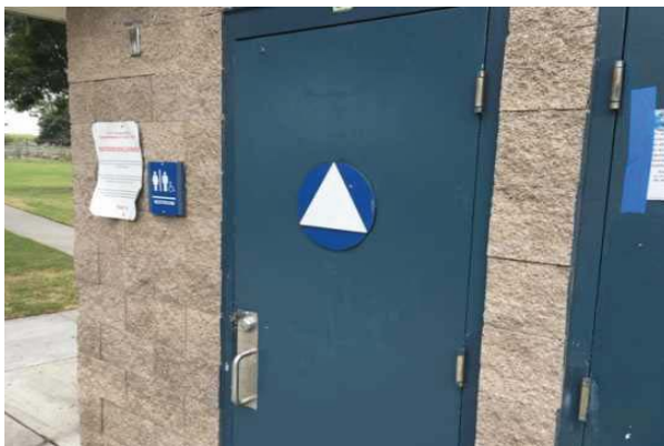
17 EXTERIOR STEEL DOOR
